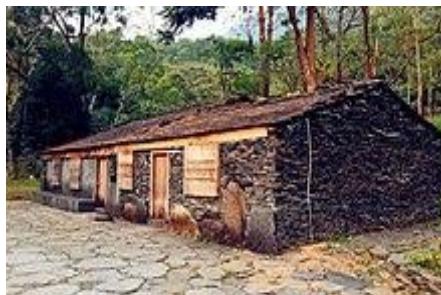
位於三地門的石板屋
